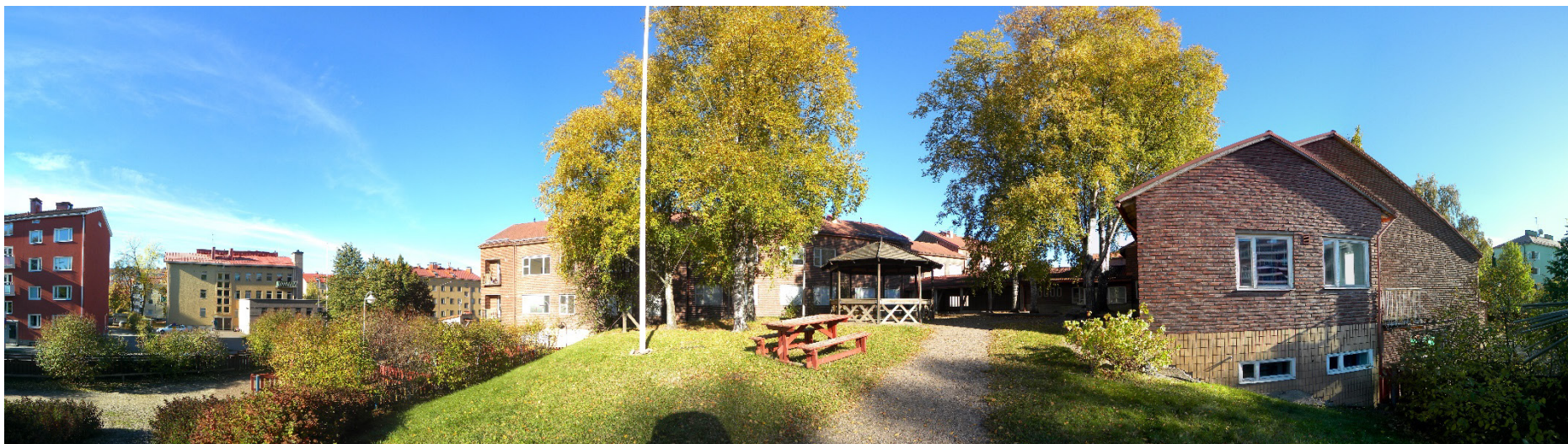
Kuva: Panoraamakuvassa vasemmalla tontin länsireunaa pensasistutuksineen, keskellä pohjoinen rakennussiipi, tarhaosa, ja oikeassa reunassa eteläinen siipi eli seimiosa.
